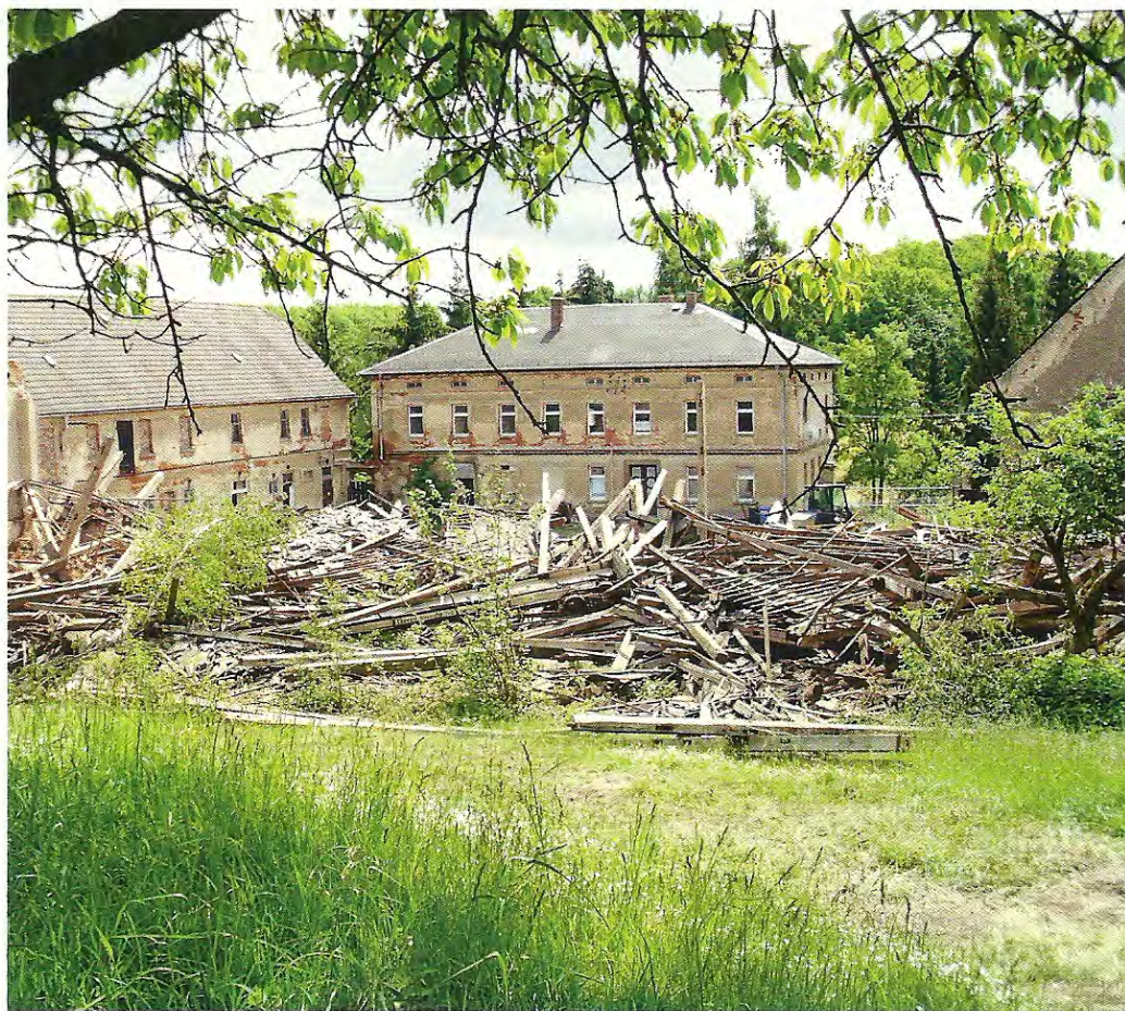
Ehemaliger Bauernhof in Beerwalde, Hauptstraße 15 – Blick von der Gartenseite auf die Abbrucharbeiten im Jahr 2016
